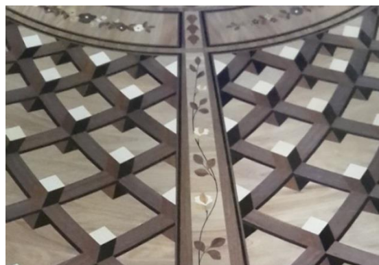
Afb. 14: Detail van een fraaie marqueterie-parketvloer.
